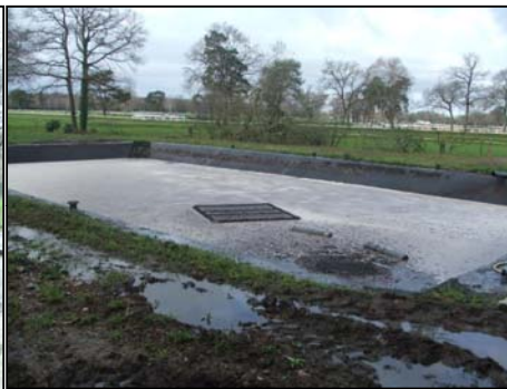
Bassin de rétention de 600 m 3 (récupération des jus)
