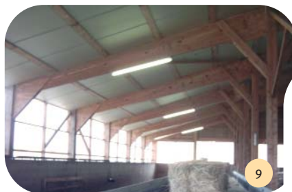
Les 2 couloirs d'alimentation sont bétonnés, surélevés de 0,50 m, équipés de cornadis.
