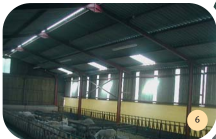
Les éléments de la ventilation.
