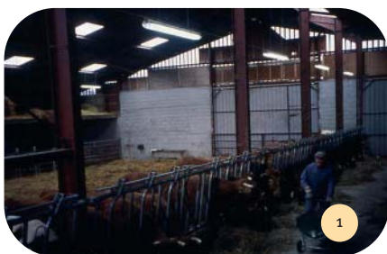
Vue intérieure du bâtiment.
